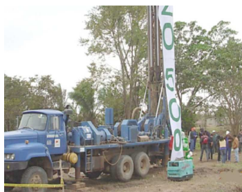
JICA供与機材と500井完成時の垂れ幕
